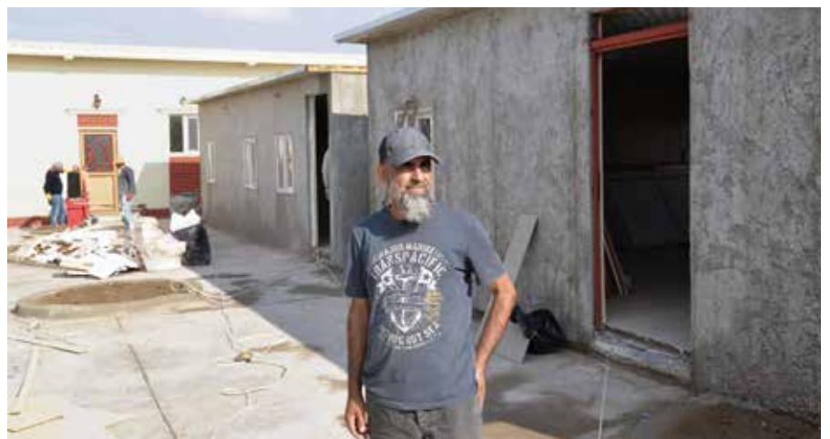
Neubau in Baghdeda (Karakosch).
