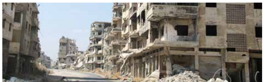
Zerstörter Straßenzug in Homs.
